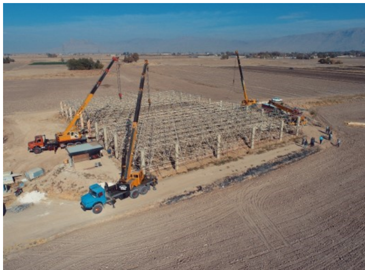
شکل 7. احداث پوشش حفاظتی سازه بزرگ دروازه پردیس پارسه، تخت جمشید، 1399
